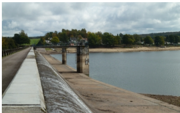
Barrage de Bouzey – Photographie DDT 88
