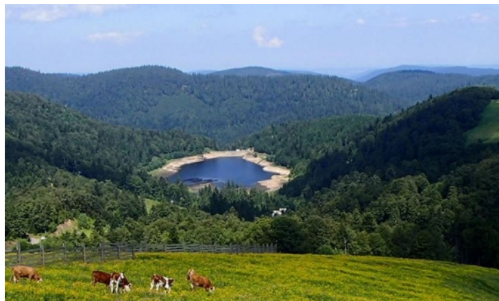
Barrage de la Lande à La Bresse – Photographie DDT 88
