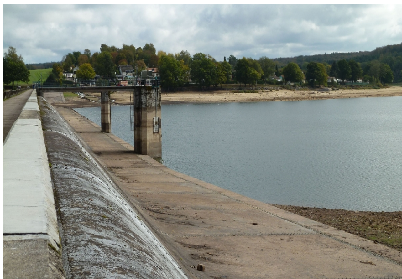
Barrage de Bouzey – Photographie DDT 88
