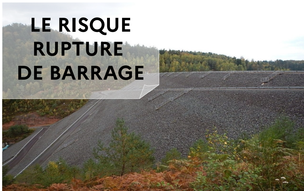
Barrage de Vieux-Pré à Pierre Percée (54) – Photographie DDT 88
