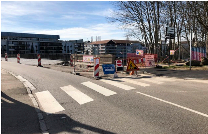
Traversée à sécuriser
