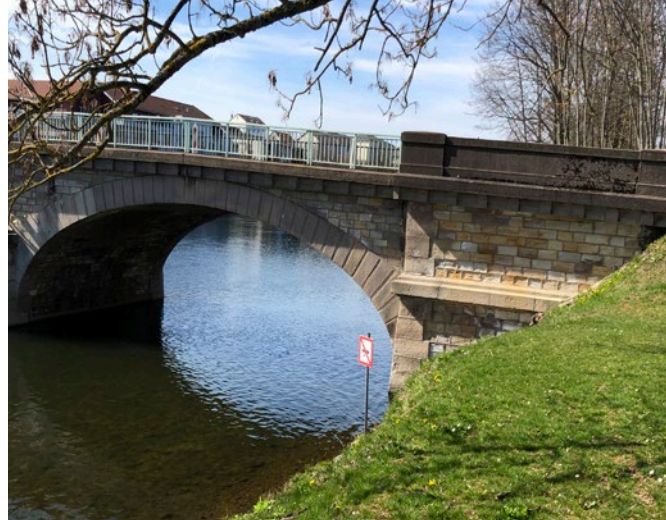
Accès piéton possible sous le pont
