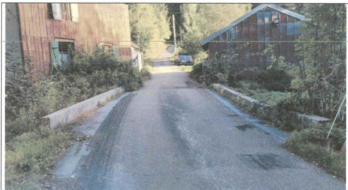
Vue supérieure de l'ouvrage d'art
