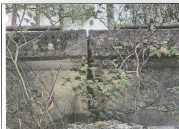
Zoom sur le joint de dilatation face amont du tablier
