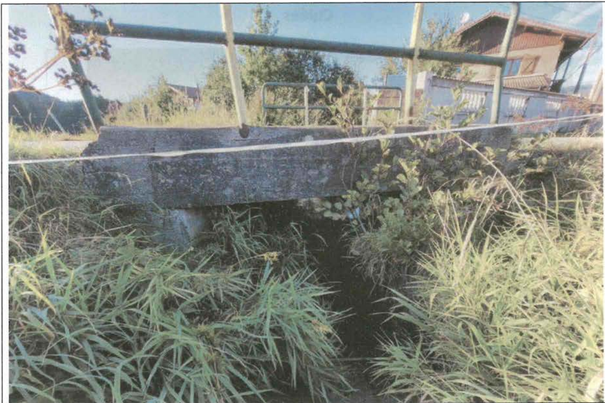
Parement est de l'ouvrage d'art
