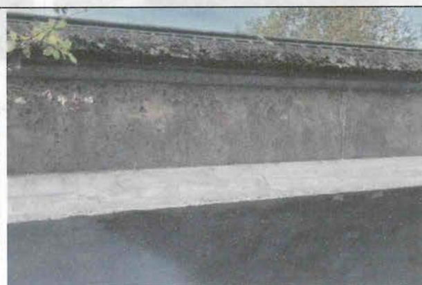
Vue inférieure du tablier et zoom sur la goutte d'eau
