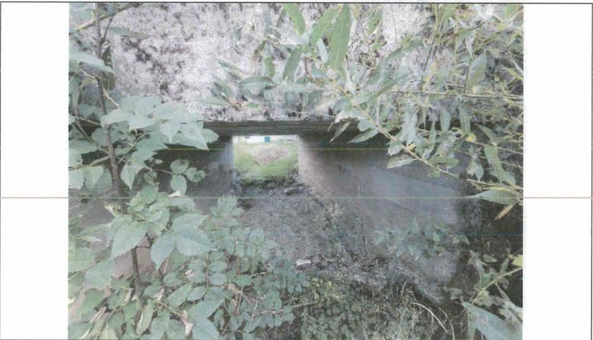
Parement ouest de l'ouvrage d'art
