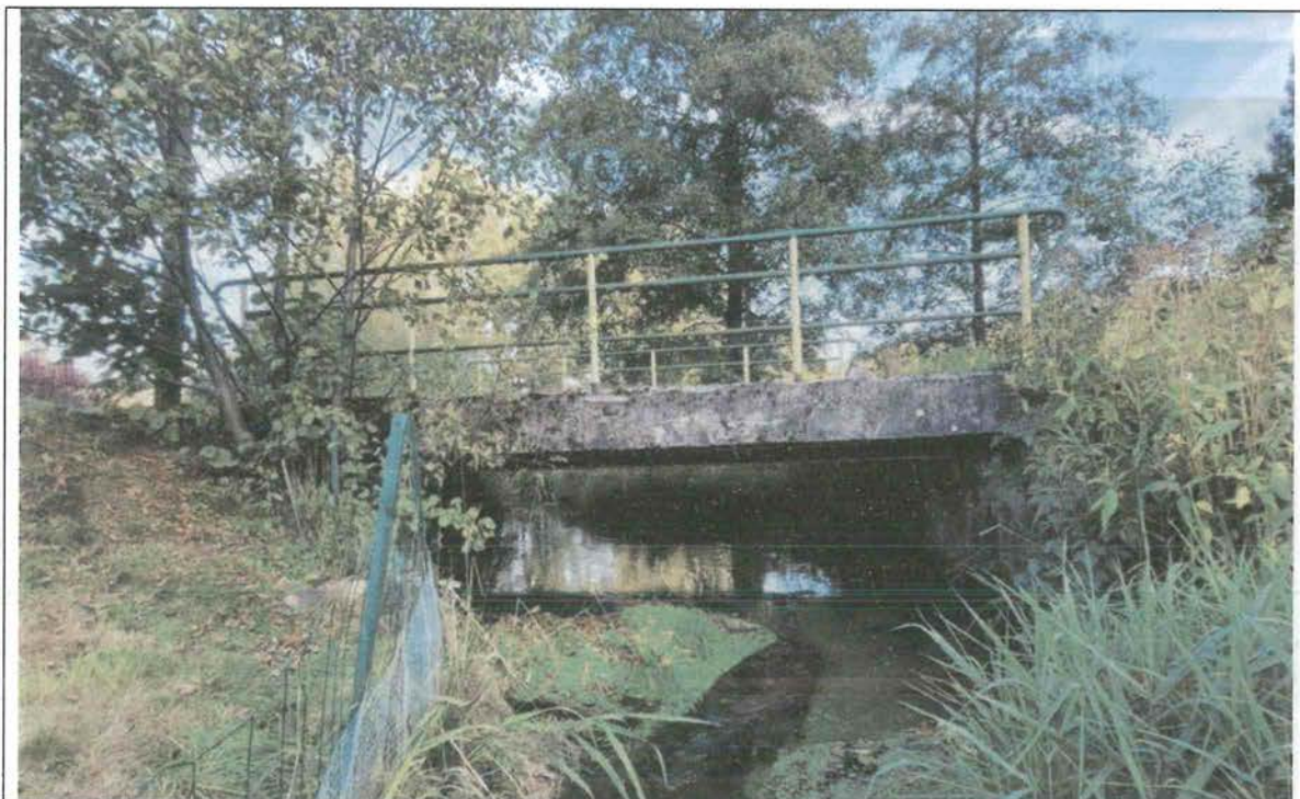
Parement ouest de l'ouvrage d'art
