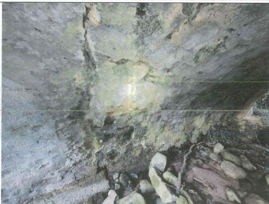
Voute maçonnée rejointoyée
