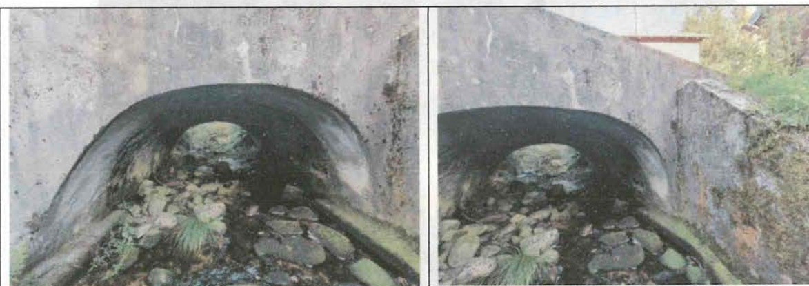
Parement aval de l'ouvrage d'art
