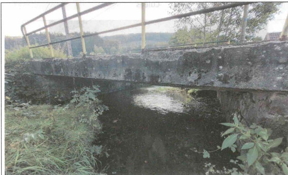
Parement est de l'ouvrage d'art
