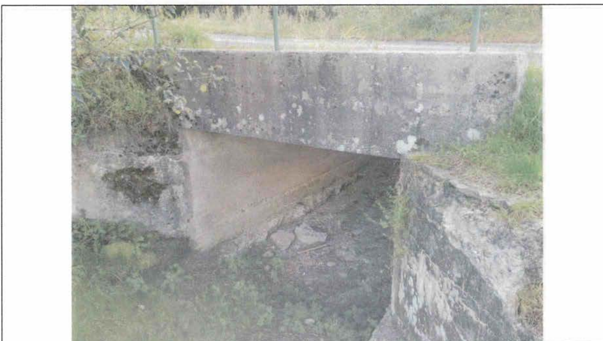
Parement est de l'ouvrage d'art
