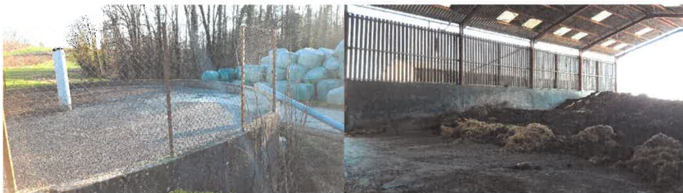
FOS1 enterrée avec grillage de sécurité
