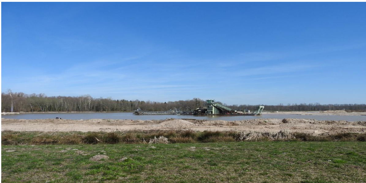
Bassin n°3 demande de renouvellement d'autorisation d'exploitation (photo B. Lalevée)
