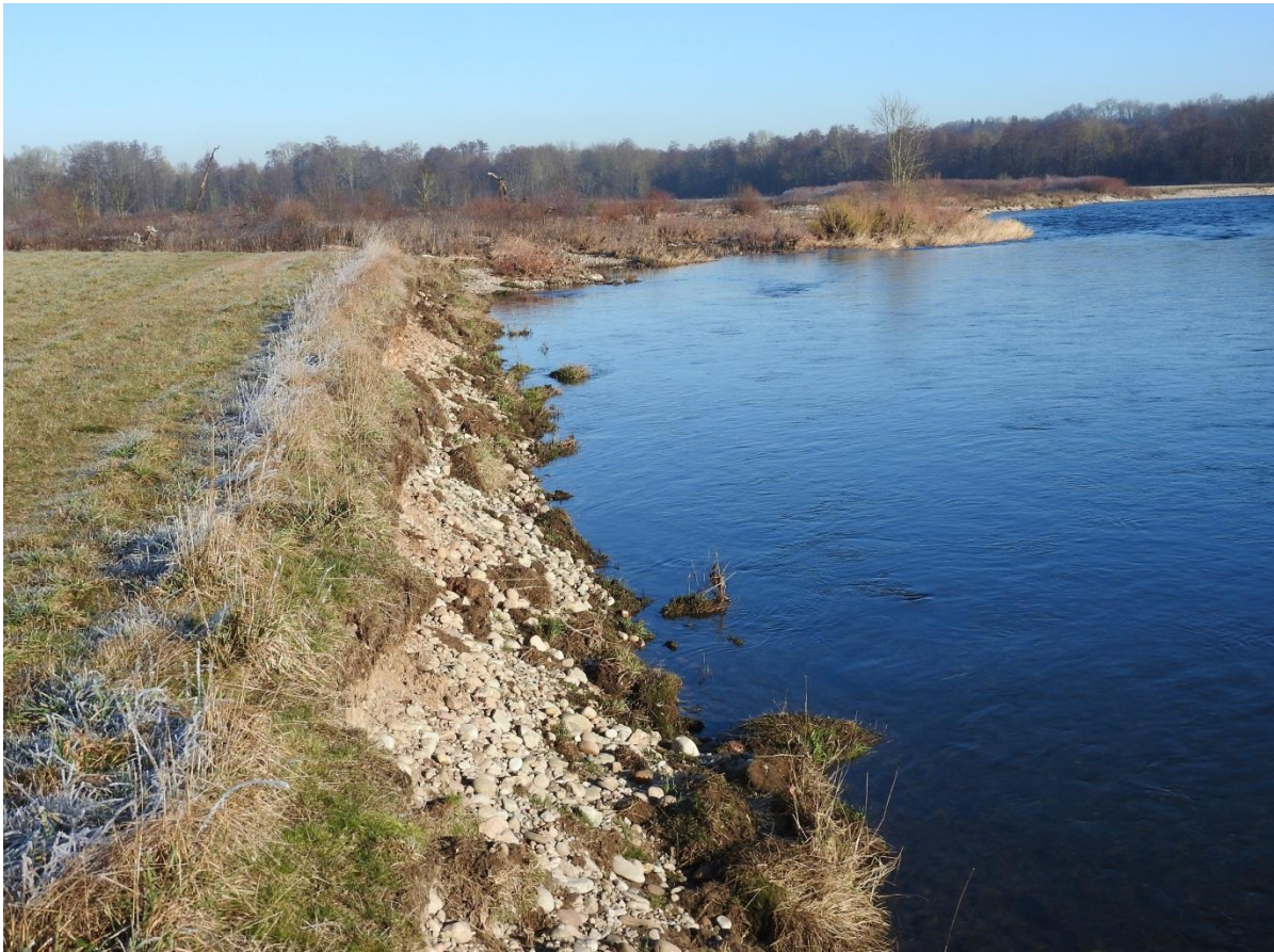
(photo B. Lalevée) Rive gauche Moselle vers le nord (Nancy). En fond zone d'expansion de crues. Projet B4 situé en aval.
