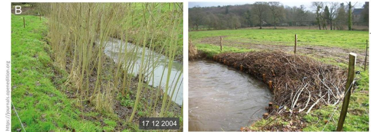
Fig. 107. Exemple de peignes pour lutter contre l'érosion de berge
